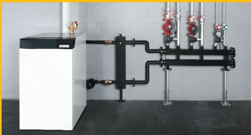
Gas-Brennwertkessel WTC-GB mit Hydraulikkomponenten (ohne Wärmedämmung)
