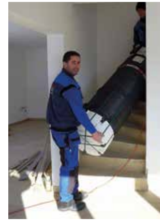
Der Kunststoff-Wärmetank wiegt nur ein Drittel eines herkömmlichen Stahlspeichers und vereinfacht so den Transport über Treppenstufen hinweg.
