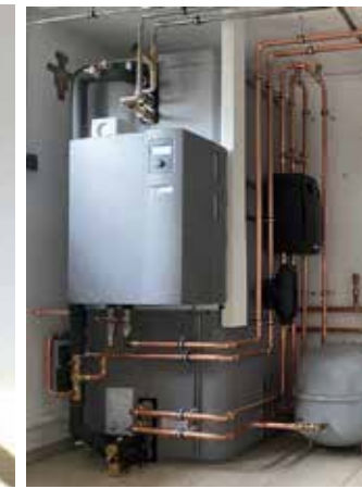
Montagebeispiel mit Anschluss-Set und Hydraulikmodul
